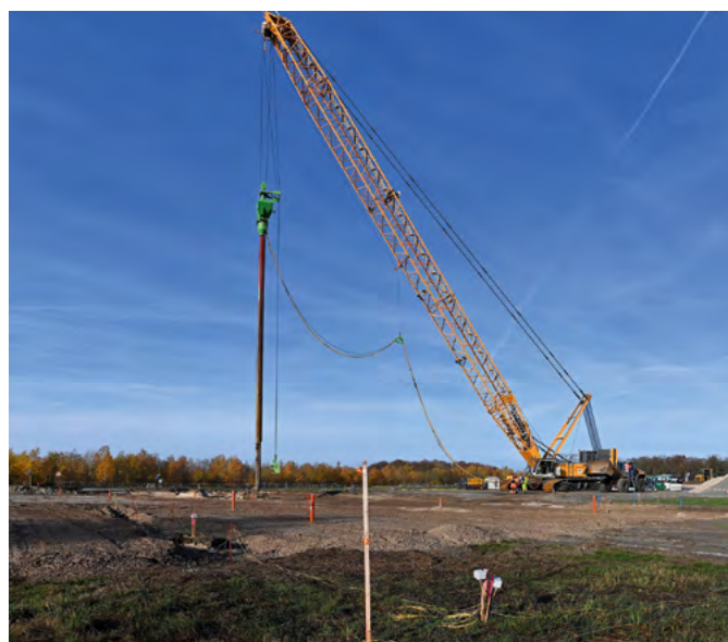
Hochkippe Borna-West Rüttelstopfverdichtung (Foto: LMBV/Christian Bedeschinski, 2018)
